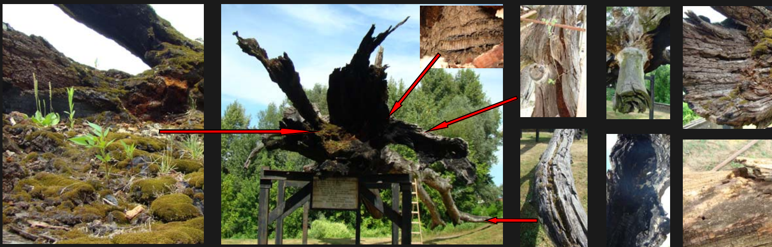
Топола ужаса, карактеристична оштећења/Poplar of Horrors, characteristic damage
