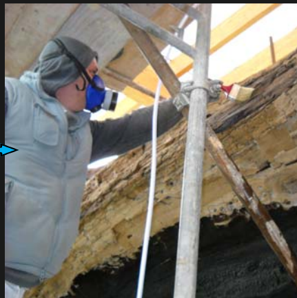
Уништавање ксилофагних инсеката /Eliminating xylophagous insects
