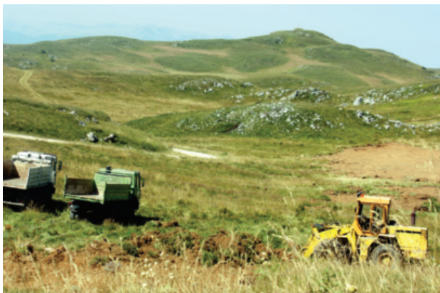
Слика 420. – Скидање површинског слоја вегетације
