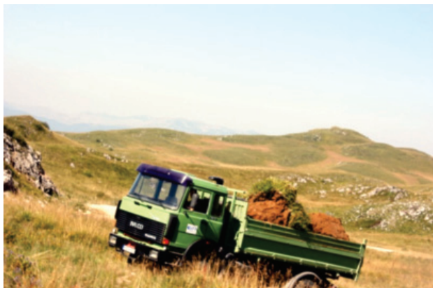
Слика 421. – Одвожење скинутог слоја земљишта
