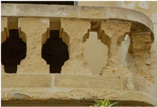
Слика 2. – Камен као балкон окружује. На први поглед, могла би бити декорација, али у суштини је уништење. Лијеви балустер је нетакнут, али десни је уништен кишамом. Да ли је то погрешан избор материјала, или само погрешна страна фасаде?
