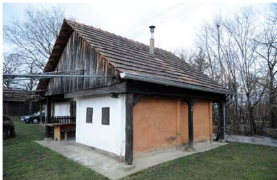
Слика 11. – Зидови нормално носе кровну конструкцију, заједно са кровним материјалом. Оригинални кровни материјал је био слама: потребна је врло лагана конструкција. Када су стигле ватросталне глинене плочице, због смањене потребе за одржавањем и веће сигурности, конструкција је морала бити јача, већа и тежа. Проблеми са земљаним зидовима су почели. Спољна, дрвена конструкција од темеља до врха чини се оправданом.
