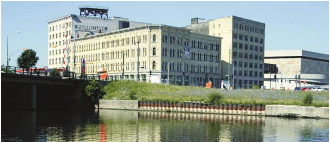
Слика 8. – Спољни изглед објекта тешке индустрије у Милвокију, Висконсин, САД
