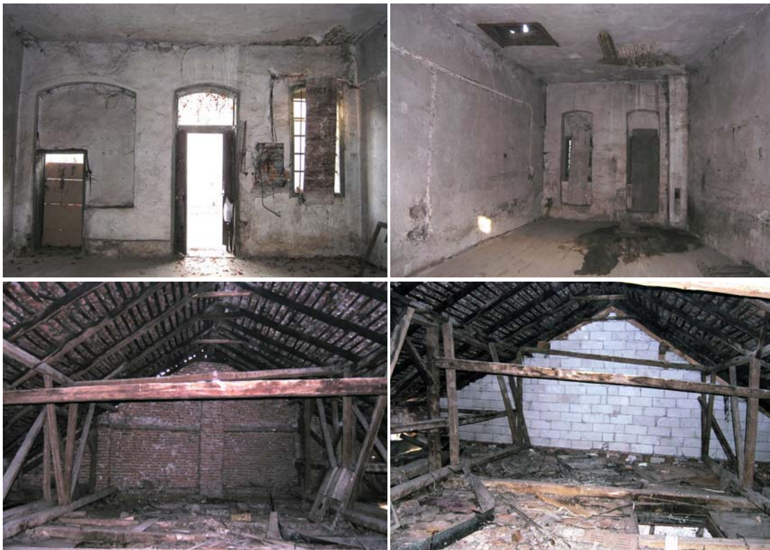
СЛИКЕ 2 – 5. – ИЗГЛЕД ЕНТЕРИЈЕРА – ЈУЖНИ И СЈЕВЕРНИ ЗИД, ПОД И ПЛАФОН (ГОРЕ) И ТАВАН – ИЗГЛЕД КОНСТРУКЦИЈЕ И ИСТОЧНОГ КАЛКАНСКОГ И ЗАПАДНОГ ЗИДА ОД СИПОРЕКСА, ИЗГЛЕД КРОВНЕ КОНСТРУКЦИЈЕ, 12. 2008. ГОД. АУТОР М. КРСТИВОЈЕВИЋ
