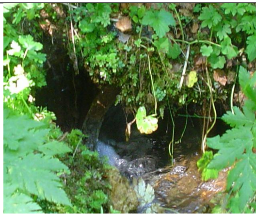
Слика 7. Прелив на каптажи Станског врела
